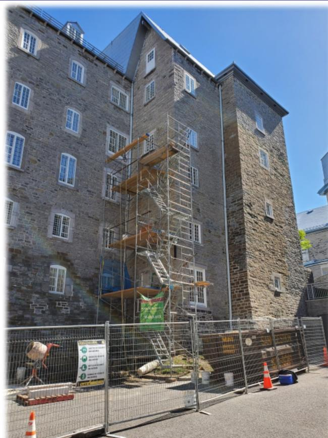
Des travaux de restauration de la maçonnerie ont été entrepris sur le mur intérieur de la Tour « des Nords », principalement où la structure de l'escalier est positionnée.
